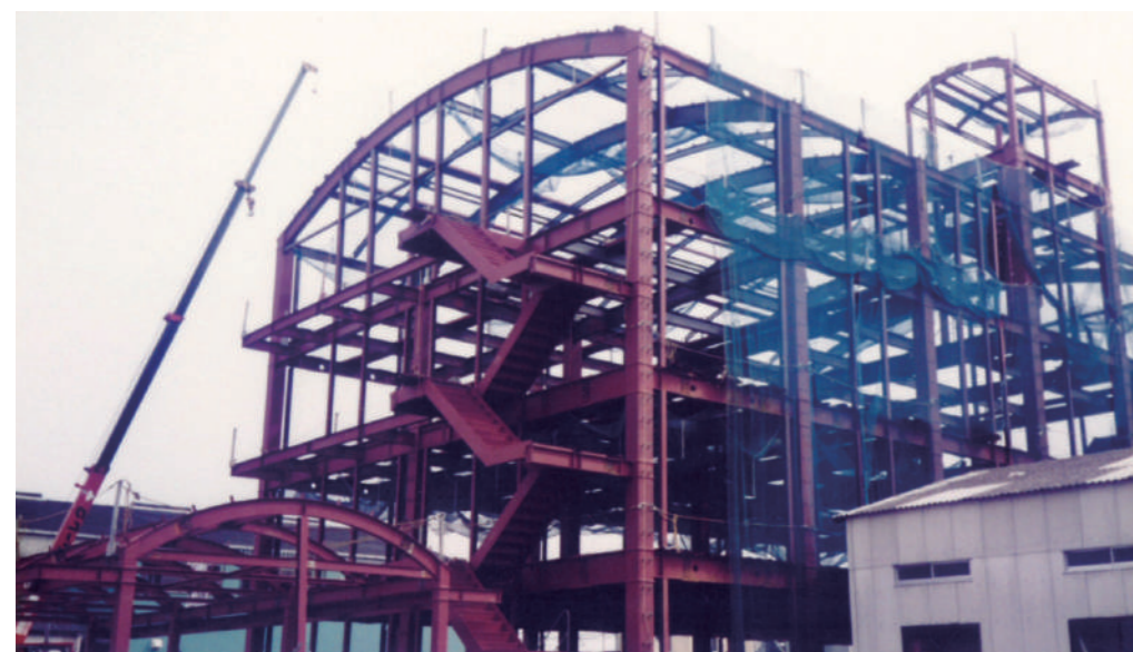
建設途中の本社ビル(1998年9月29日)
